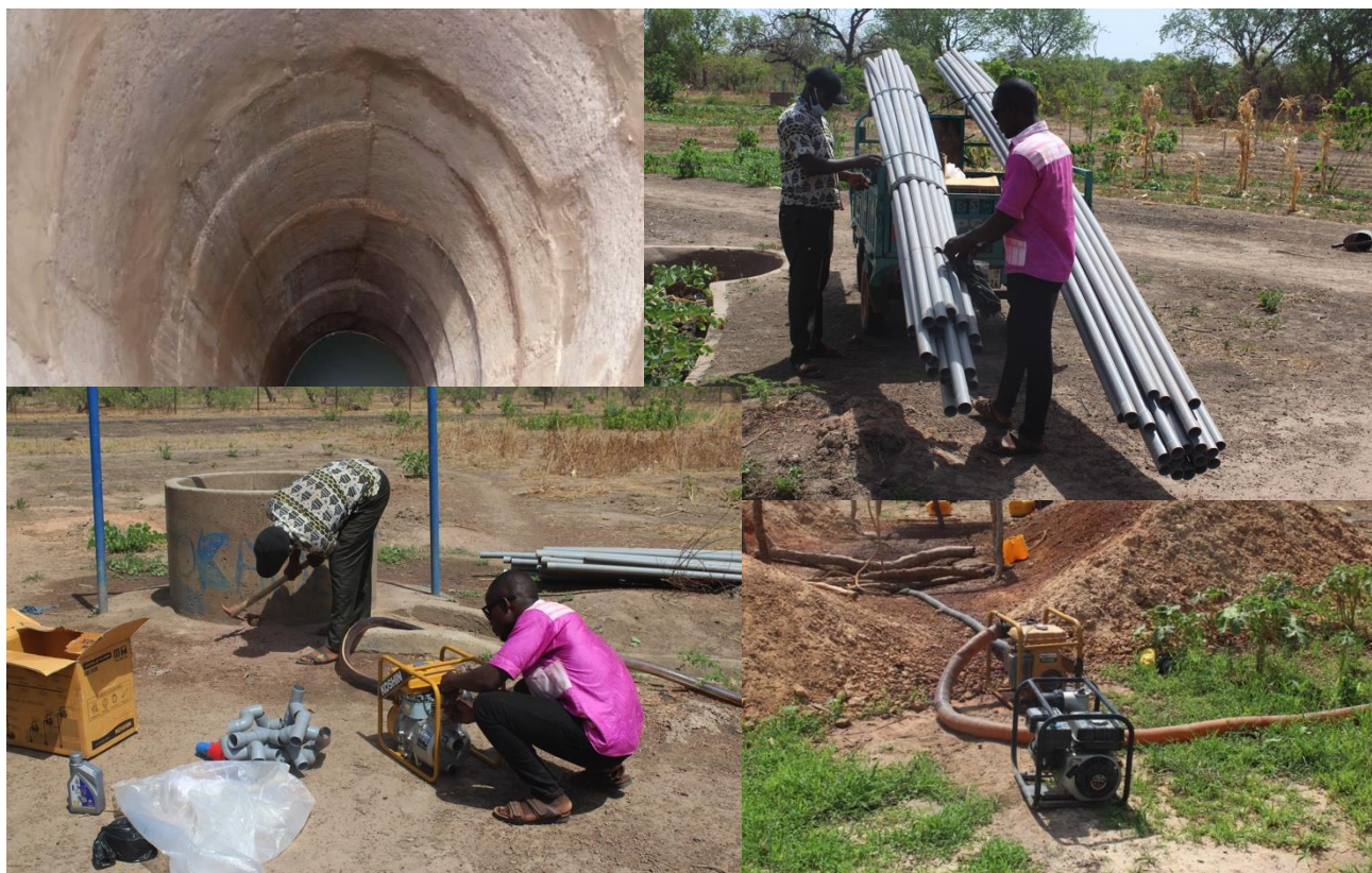
Busage du 3 ème puits – Mise en place du système d'irrigation
